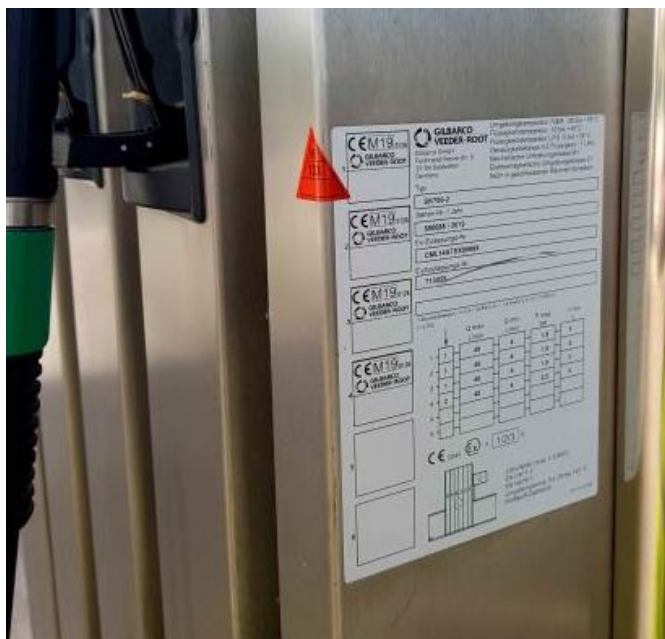
Abb. 5: Kennzeichnung einer instandgesetzten Straßenzapfsäule durch Anbringung eines Instandsetzerkennzeichens (rotes Dreieck)
